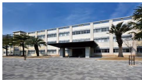
改修後のB1棟
