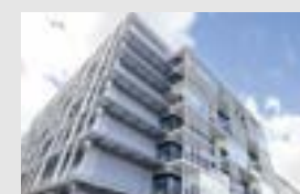
2024年4月 中百舌鳥キャンパス 工学新棟・新センター棟 開設
