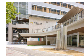
【2025年4月開設】看護学部学舎C棟
